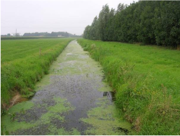
Foto 6.7: de Laarakkerse Waterleiding bestaat in de huidige situatie uit een genormaliseerde waterloop met steile oevers
