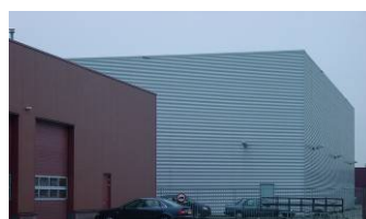
Verhoogde bedrijfshal Houten – Het Rondeel
